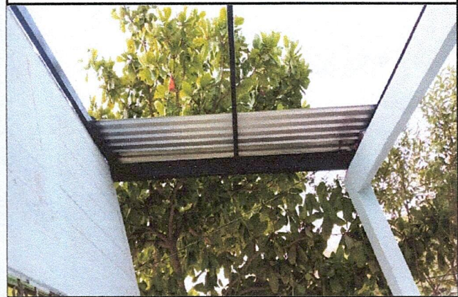
Foto 4: COLOCACION DE LAMINA
