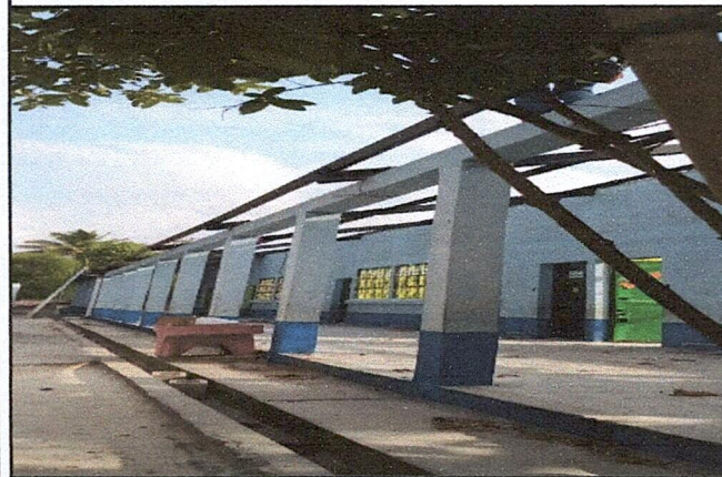
Foto 3: COLOCACION DE LAMINA
